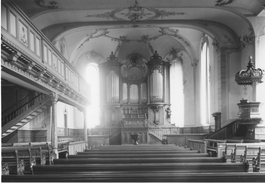
Situation um 1950: Blick in den Chor sowie Teilansicht der relativ hoch liegenden Seiten (Nord-) Empore [© 7]
